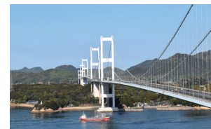
来島海峡大橋
