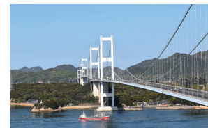
来島海峡大橋
