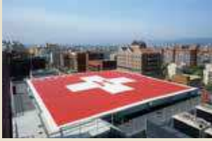
屋上ヘリポート
