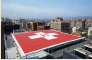
屋上ヘリポート
